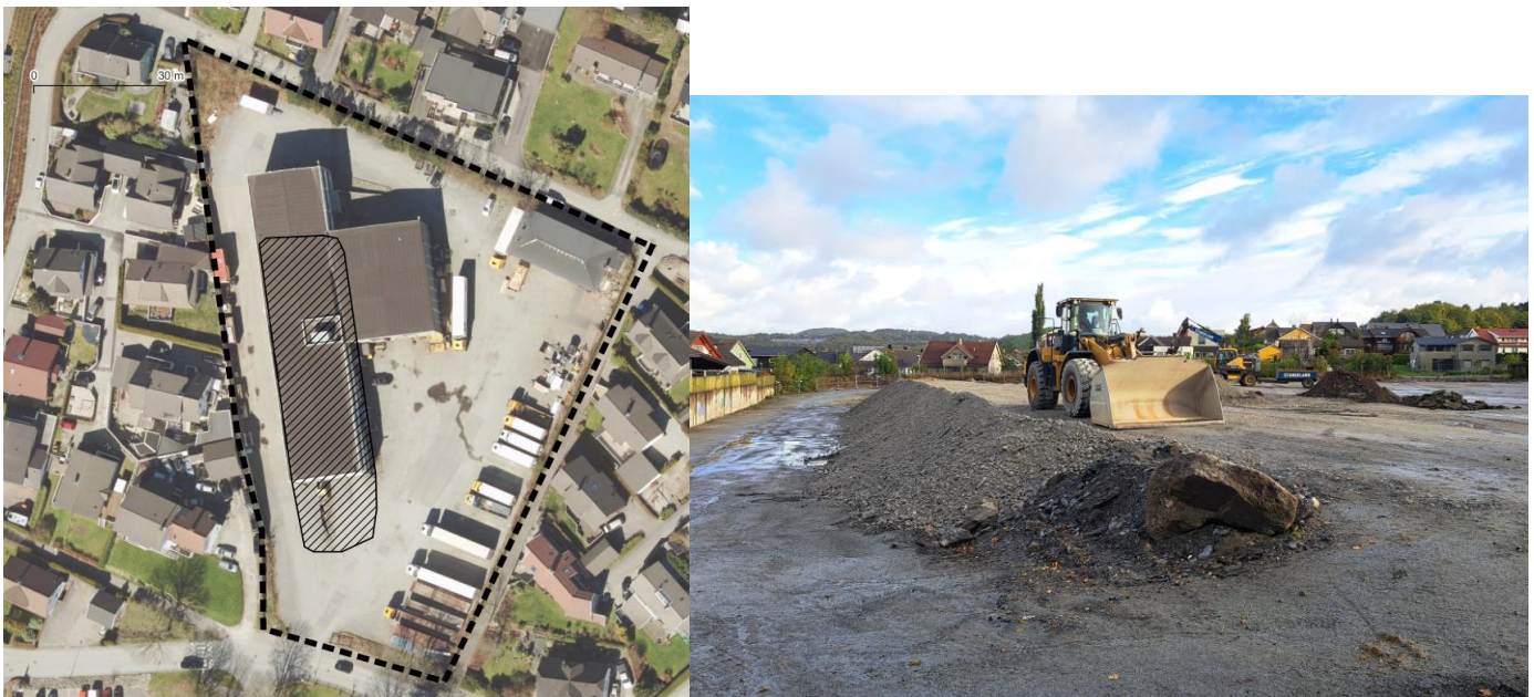
Figur 6. Betong i revne bygninger ble knust og benyttet som fyllmasser for å heve terrenget under den tidligere hovedbygningen på tomta. Fyllingen har en metning på 2-4 m. Venstre bilde: omtrentlig utbredelse av fylling. Høyre bilde: foto av eksisterende fylling. Bildet er tatt fra sør mot nord.
